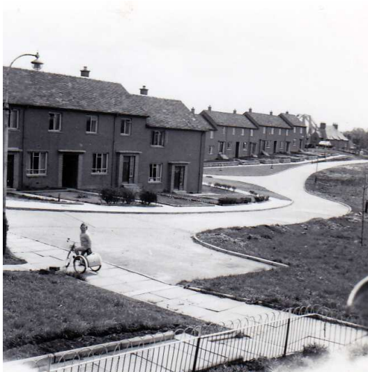
Brock Street - pre flats
